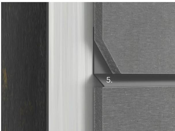
Das L-Profil wird für horizontale Fugen eingesetzt und sollte in der gleichen Länge wie die Tafel zugeschnitten werden.
